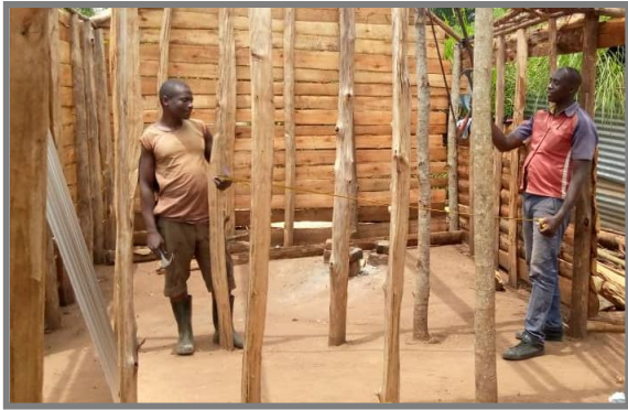
Oben: Bau eines Hühnerstalls.
